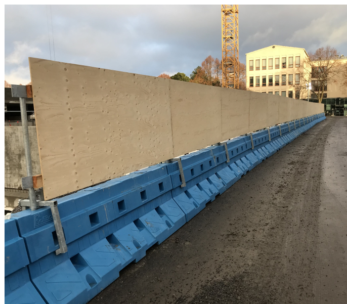
Obrázek 27: Ohraničení staveniště pomocí konstrukce upevněné na svodidlech
