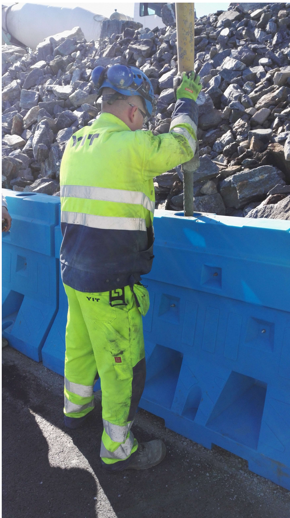
Obrázek 12: Plnění svodidel SOFIBOX betonovou směsí
