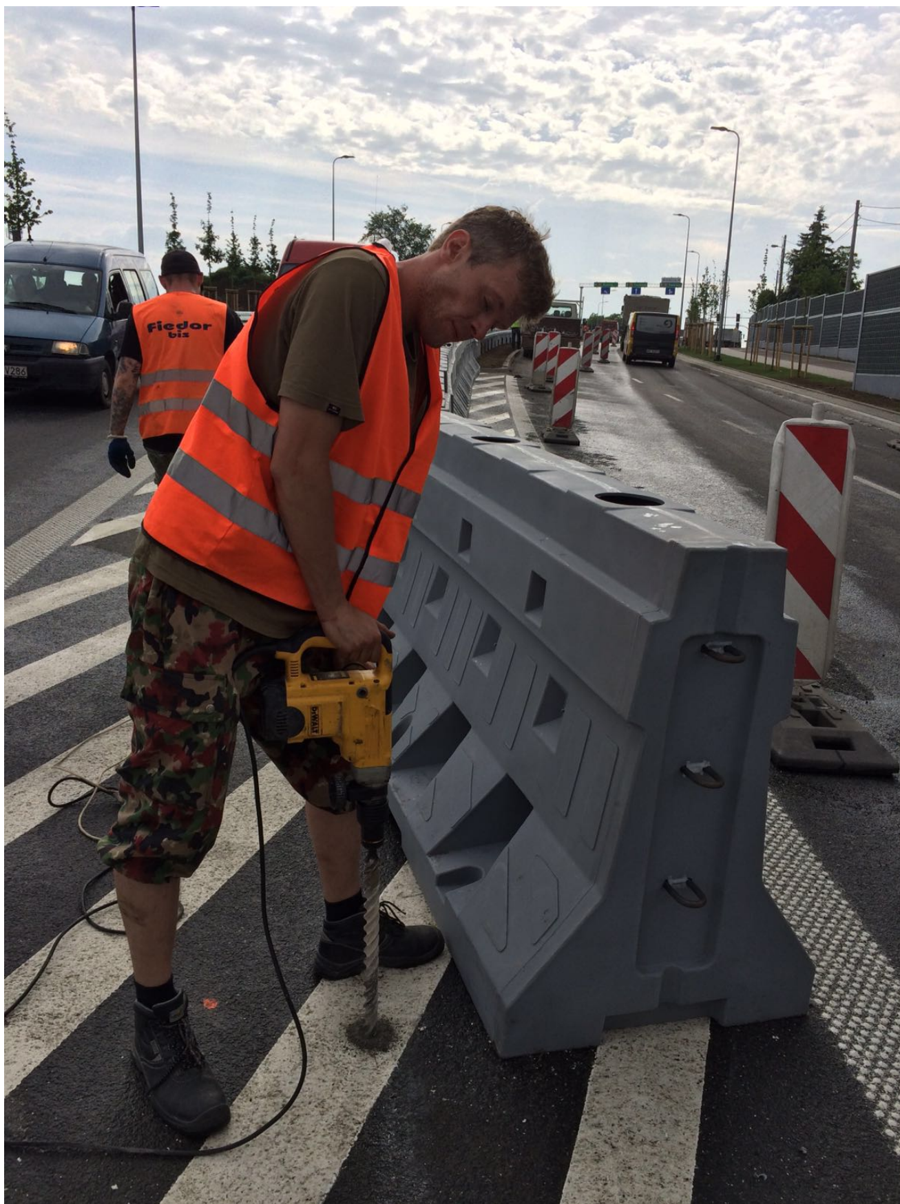
Obrázek 11: Montáž svodidel SOFIBOX (vrtání otvoru pro kotevní tyč)
