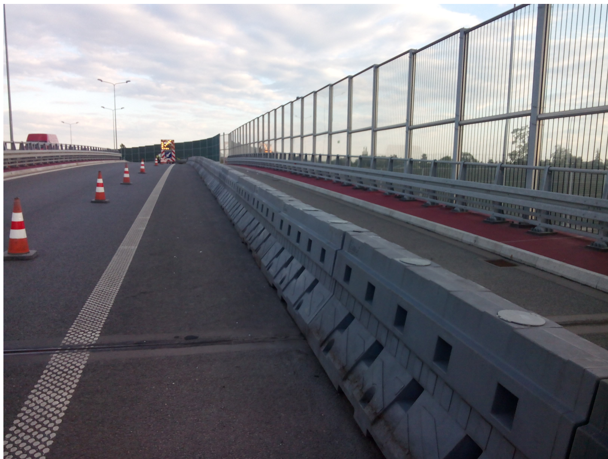
Obrázek 14: Realizace svodidel SOFIBOX na mostě
