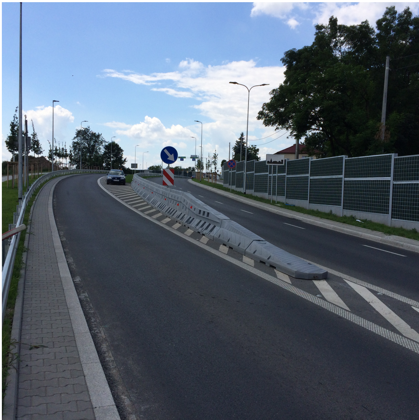
Obrázek 15: Realizace svodidel SOFIBOX na silnici
