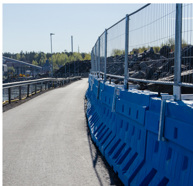
Obrázek 28: Konstrukce plotu upevněná na svodidlech
